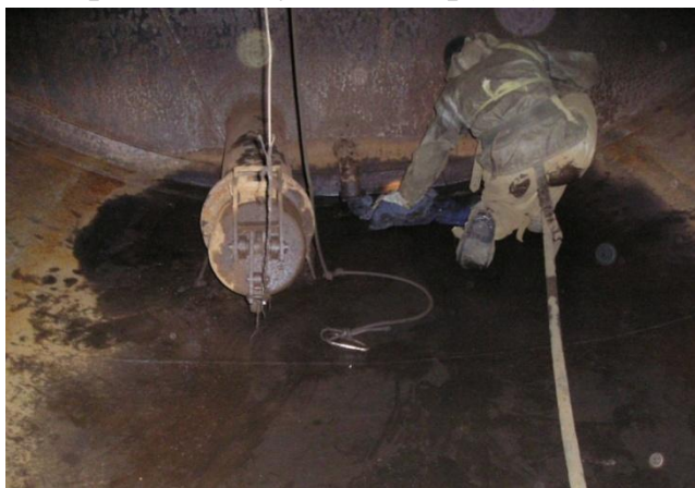
Рис. 1. Зачистка полости РГС от остатков жидкого нефтепродукта
